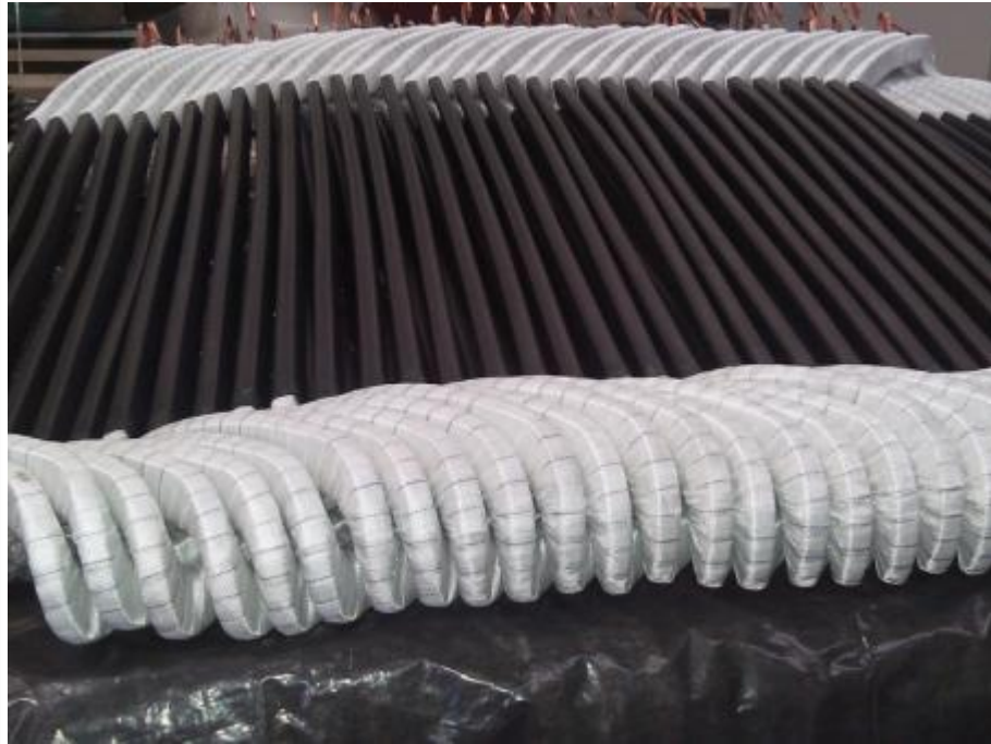
Rebobinamento de Motor AEG 1200KW. 6,6KV
